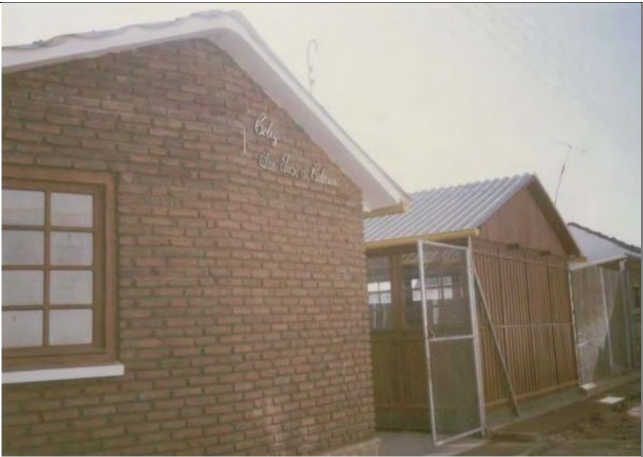
Se comienza, no, avance de las obras del colegio.
